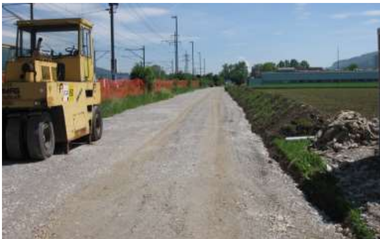
Neues Trasse der Industriestrasse (Sicht nach Osten)
